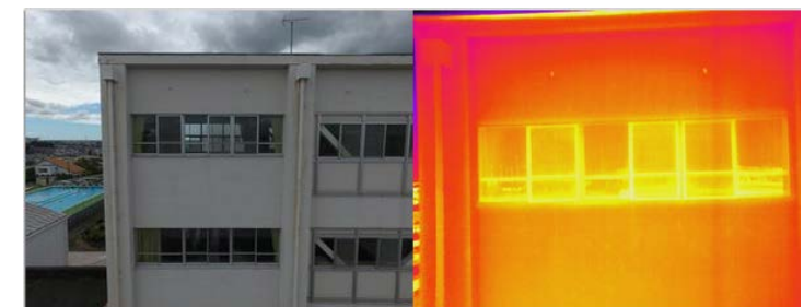
③午前と午後のフライトによる画像で壁面の損傷等を点検
